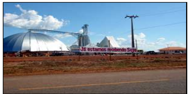
Armazém em pleno funcionamento
