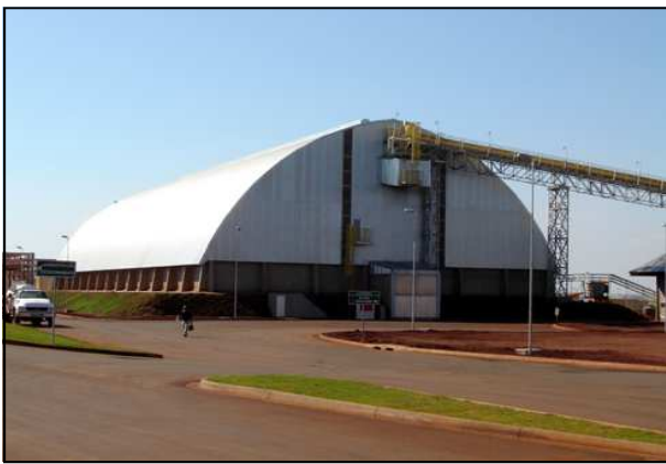
Unidade já em funcionamento
